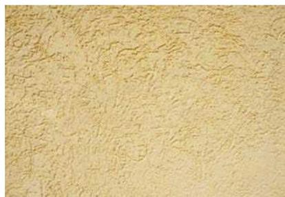
Les peintures minérales ne forment pas de pellicule et le vieillissement se fait par une décomposition propre des couches. Pour la rénovation, un simple nettoyage suffit.
